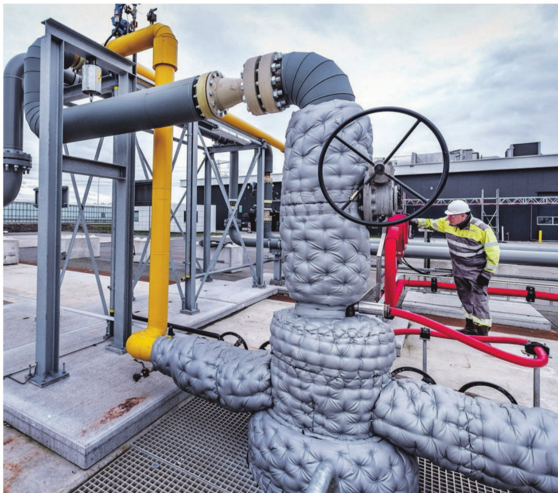
Deze aardwarmte-installatie in Naaldwijk levert energie aan 56 tuinders.
