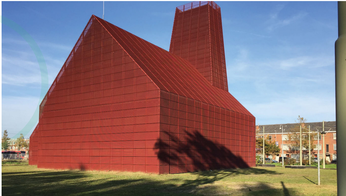
Het aardwarmteproject aan de Leyweg naast het HAGA-ziekenhuis in Den Haag laat zien hoe een aardwarmte-installatie is in te passen in de gebouwde omgeving.
