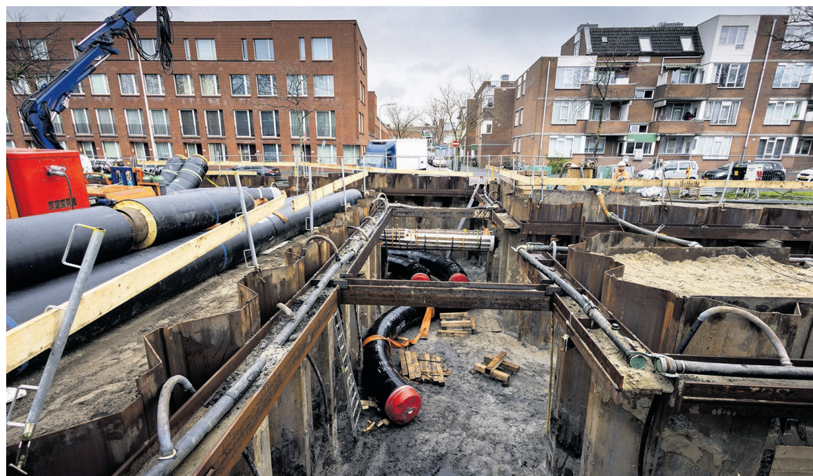
Werk aan de aanleg van het Haagse warmtenet Warmtelinq, afgelopen voorjaar. FOTO LAURENS VAN PUTTEN, ANP
